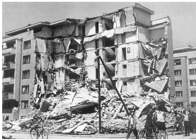
Slika 2. Karakteristična zgrada nakon zemljotresa u Skoplju [14] Figure 2. Characteristic building damaged after Skopje earthquake [14]
