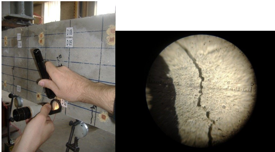
Slika 3. Postupak mjerenja širine pukotina Figure 3. Measurement of the crack width
